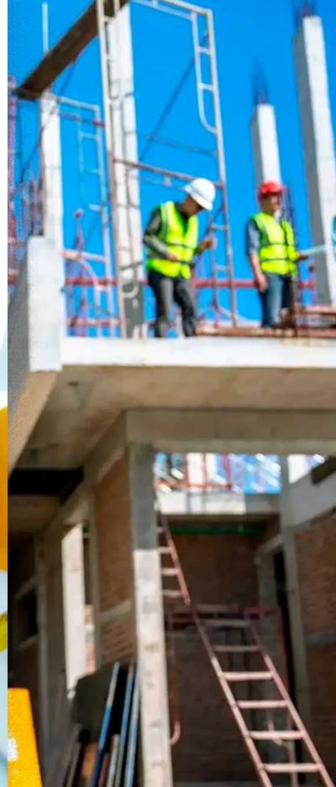
EXECUÇÃO DE OBRAS
