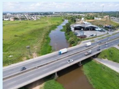
Ampliação de capacidade BR-101/SC
